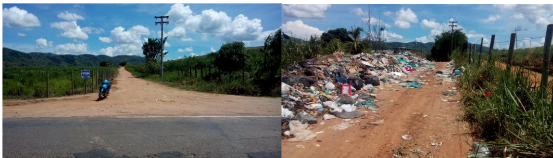
Figura 2- Entrada do lixão. Fonte: Autores, 2016.
